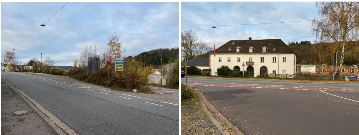
Abbildung 4: Blick von der Losheimer Straße Richtung Zufahrtsbereich zum Neubau (links) bzw. auf das Baudenkmal (rechts) Foto: KomCon GmbH
