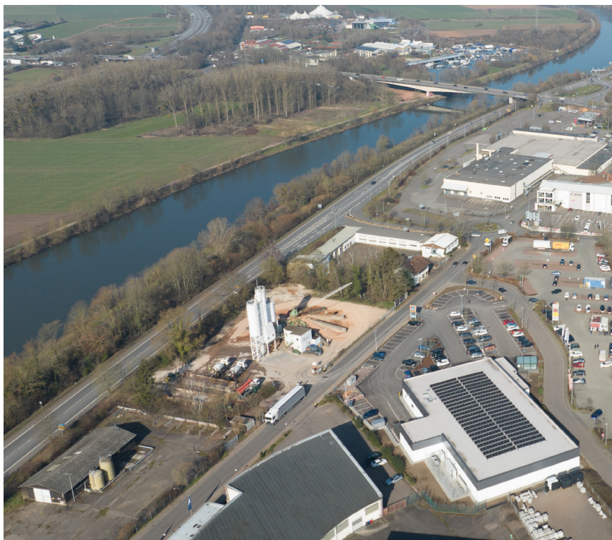
Drohenaufnahme aus südlicher Richtung auf Plangebiet und weitere Nutzung / Bebauung Rieffstraße
