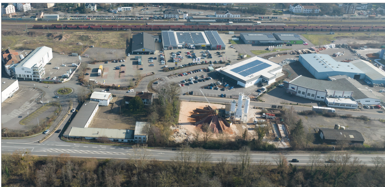
Drohenaufnahme aus westlicher Richtung auf südliches Plangebiet (u. a. Betonwerk); im Hintergrund Bahngleise und Bahnhof Merzig
