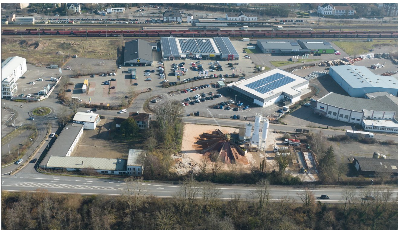
Drohenaufnahme aus westlicher Richtung auf südliches Plangebiet (u. a. Betonwerk); im Hintergrund Bahngleise und Bahnhof Merzig
