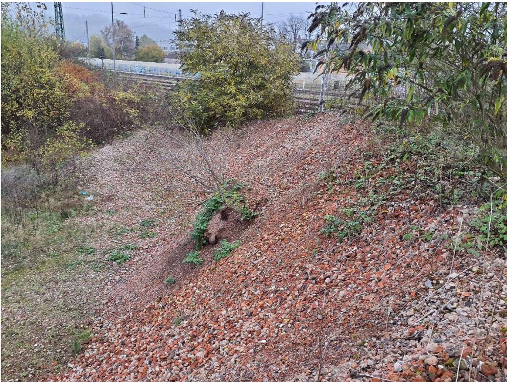
Abbildung 5: Aufschüttung aus Schotter und Split im Südosten
