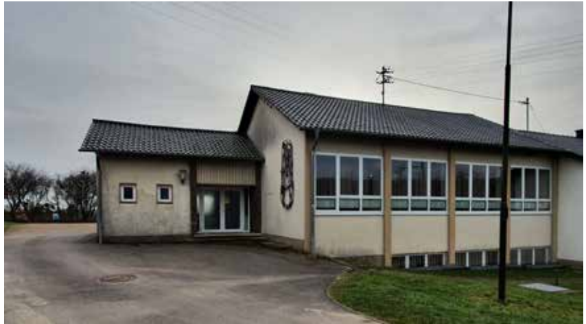
Schulungsraum der Freiwilligen Feuerwehr samt Vorflächen mit Sanierungs- und Aufwertungsbedarf im Bereich der Lilienstraße
