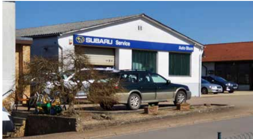
Abgelegener Gewerbebetrieb im Bereich der Straße „Zum Saargau“ mit Aufwertungsbedarf
