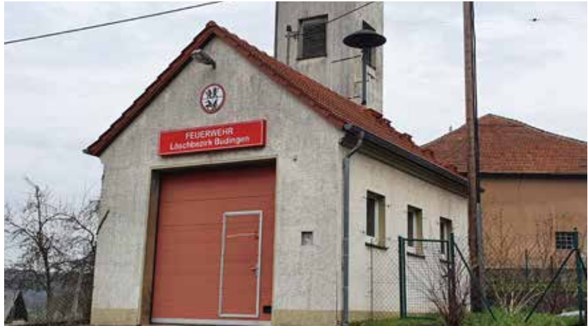
Feuerwehrgerätehaus mit Sanierungs- und Aufwertungsbedarf im Bereich der Straße „Zum Saargau“
