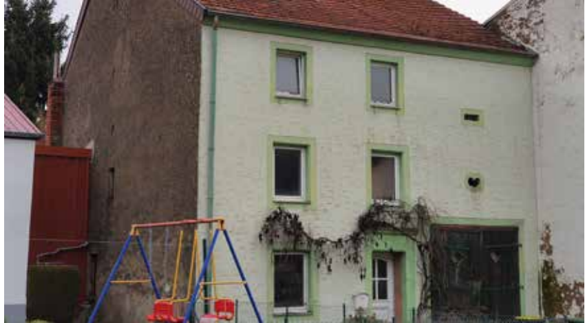
Leerstehendes Wohngebäude im Bereich der Lilienstraße
