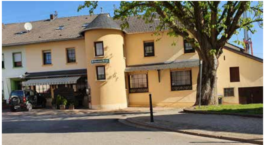
Pension mit Sanierungs- und Aufwertungsbedarf im Bereich Lilienstraße/ Im Neugarten
