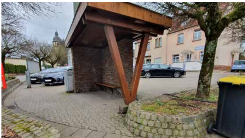
Platzfläche mit Aufwertungsbedarf im Kreuzungsbereich Luxemburger Straße/ Laurentiusstraße/ „Zum Schotzberg“
