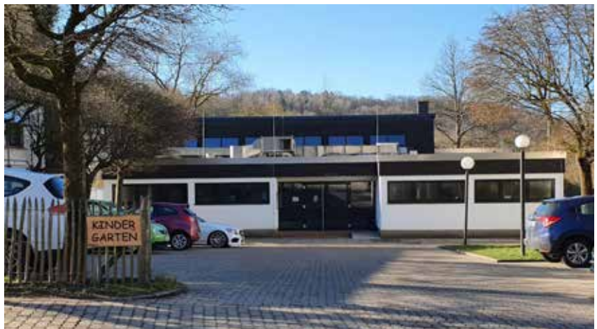
Vereinshaus mit Sanierungs- und Aufwertungsbedarf im Bereich der Ortsdurchfahrt „Honzrather Straße“ (L 346)
