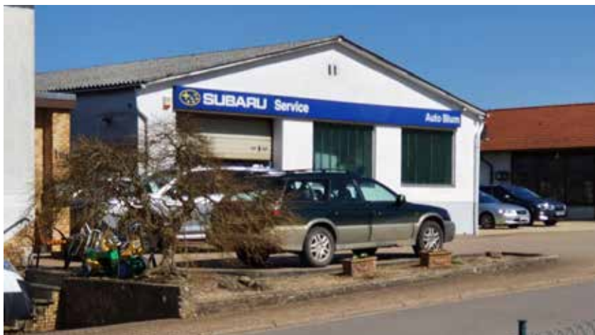
Abgelegener Gewerbebetrieb im Bereich der Straße „Zum Saargau“ mit Aufwertungsbedarf
