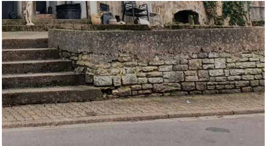
Ortsbildbeeinträchtigende Gestaltung von Gebäudevorflächen/ Nutzung unbebauter Grundstücksflächen
