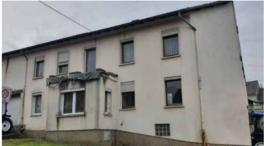
Leerstehendes Wohngebäude im Bereich der Straße „Zum Saargau“
