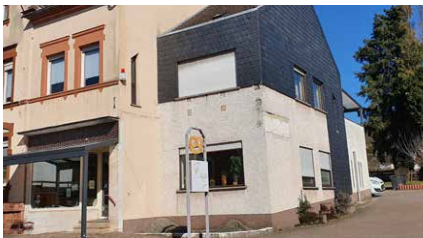
Bäckerei mit Sanierungs- und Aufwertungsbedarf im Bereich der ehem. Bundesstraße „Bezirkstraße“
