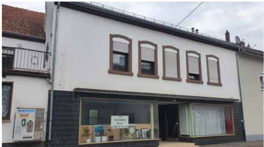
Gewerblicher Leerstand im Bereich der Ortsdurchfahrt „Luxemburger Straße“ (L 170)
