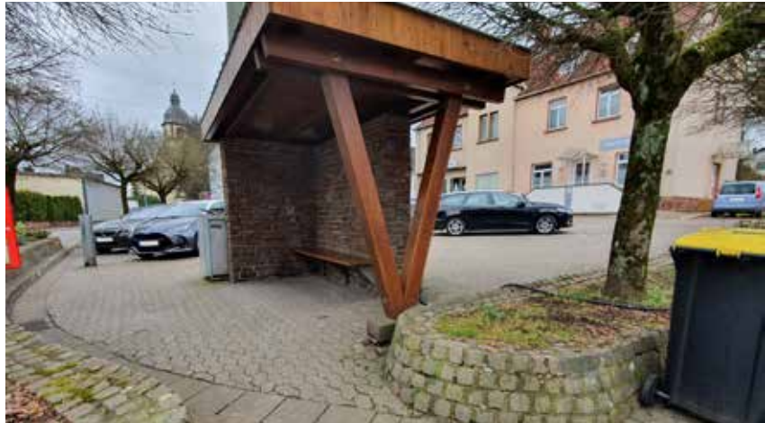
Platzfläche mit Aufwertungsbedarf im Kreuzungsbereich Luxemburger Straße/ Laurentiusstraße/ „Zum Schotzberg“
