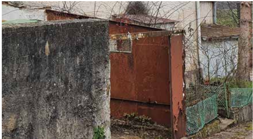
Ortsbildbeeinträchtigende Gestaltung von Gebäudevorflächen/ Nutzung unbebauter Grundstücksflächen
