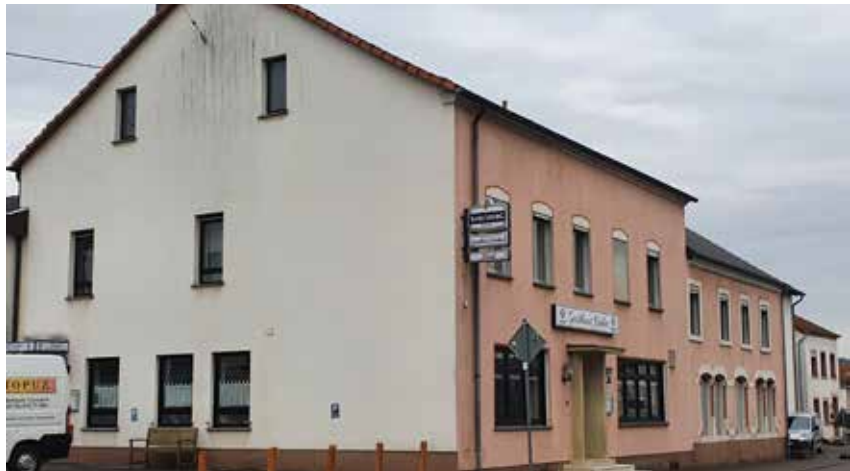
Gasthaus mit Sanierungs- und Aufwertungsbedarf im Kreuzungsbereich Luxemburger Straße (L 170)/ Gartenstraße
