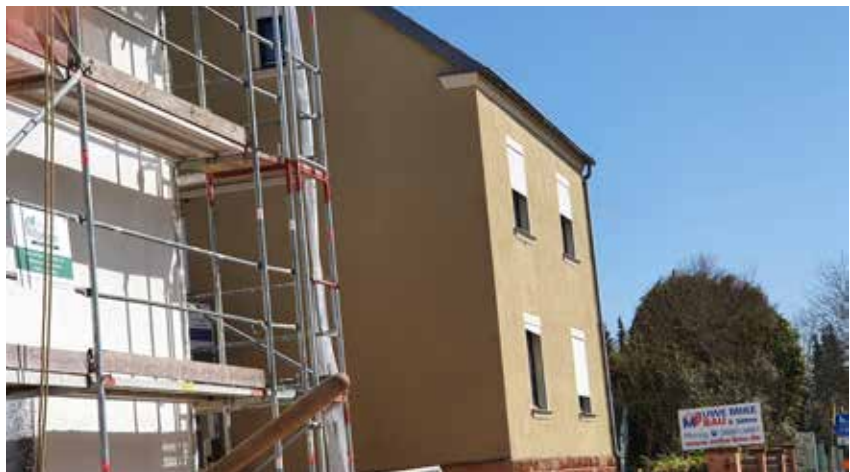
Leerstehendes Wohngebäude im Bereich des südlichen Ortseinganges in der Bezirkstraße
