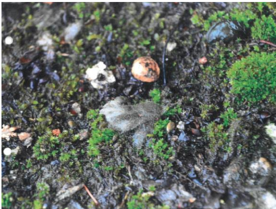
Vorhandene KMF im Bereich der Abrissfläche – Aufnahme von 03.08.2021
