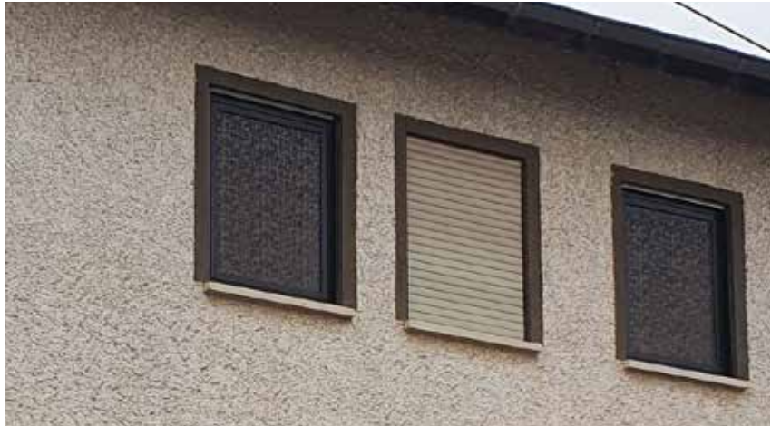
Modernisierungs- und instandsetzungsbedürftiges Gebäude mit mittlerem Bedarf
