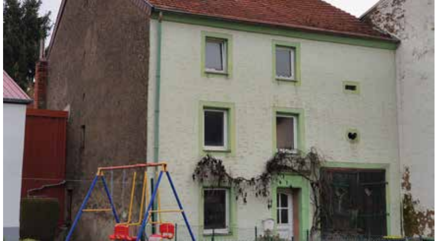
Leerstehendes Wohngebäude im Bereich der Lilienstraße
