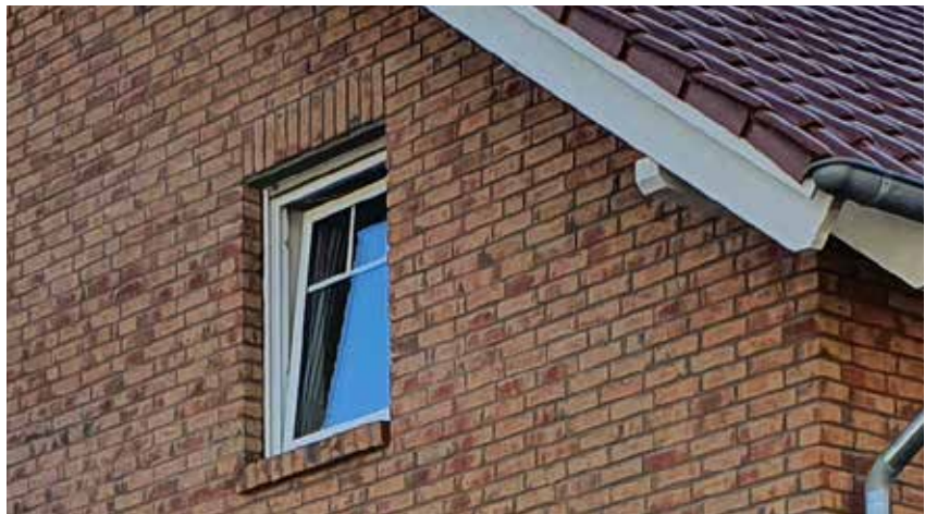
Modernisierungs- und instandsetzungsbedürftiges Gebäude mit geringem Bedarf
