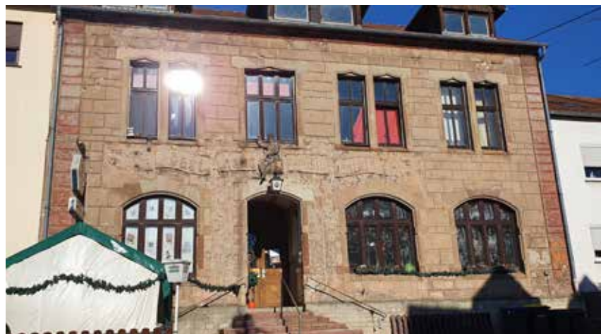
Denkmalgeschützter Gasthof „Zum Blütental“ mit Sanierungs-/ Aufwertungsbedarf im Bereich der Straße „Langgarten“
