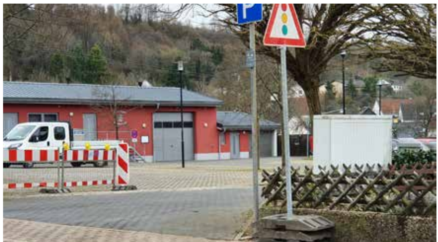
Gestaltungs-/ aufwertungsbedürftige Platzfläche im Bereich des Gemeinschaftszentrums im Bereich der Ortsdurchfahrt „Honzrather Straße“ (L 346)
