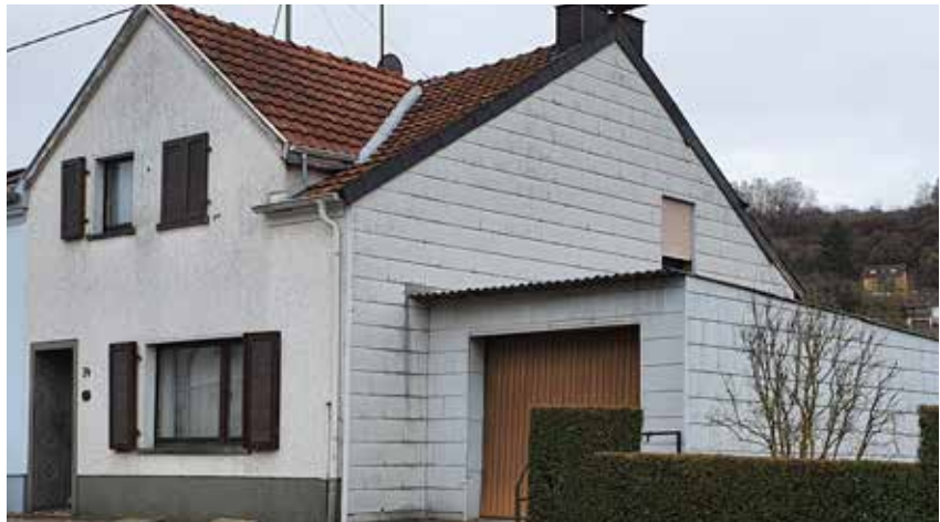
Leerstehendes Wohngebäude im Bereich der Ortsdurchfahrt „Honzrather Straße“ (L 346)
