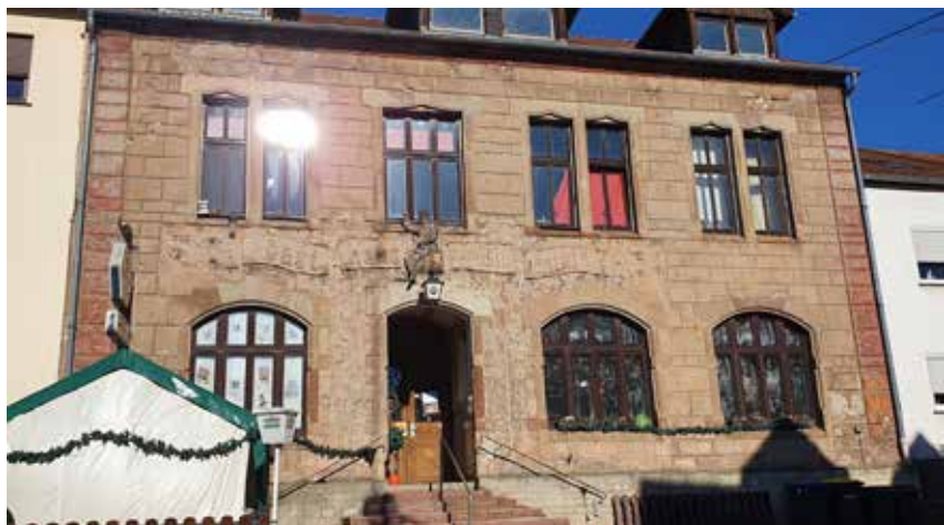
Denkmalgeschützter Gasthof „Zum Blütental“ mit Sanierungs-/ Aufwertungsbedarf im Bereich der Straße „Langgarten“
