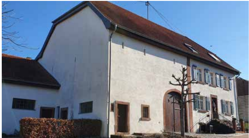
Denkmalgeschütztes Bauernhaus im Bereich der Ortsdurchfahrt „Honrrather Straße“ (L 346)
