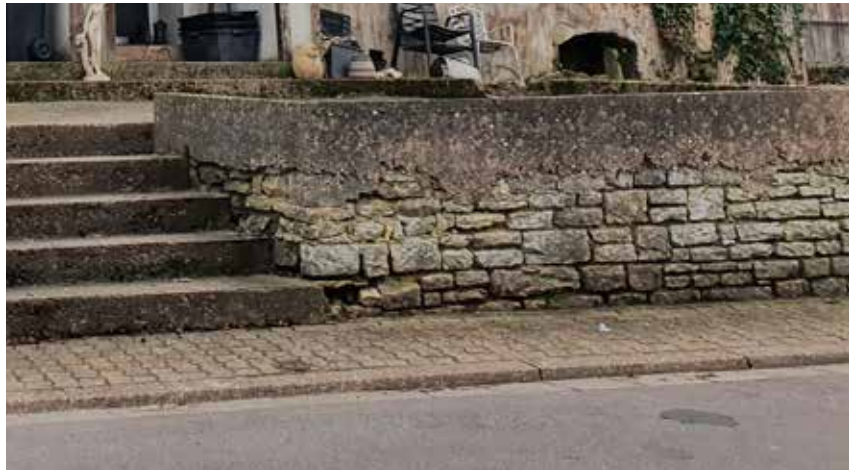
Ortsbildbeeinträchtigende Gestaltung von Gebäudevorflächen/ Nutzung unbebauter Grundstücksflächen
