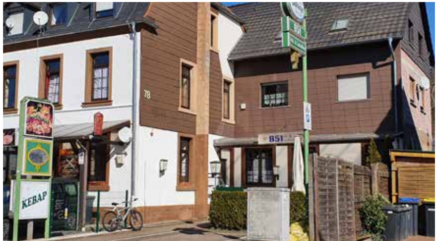
Gastronomiebetrieb mit Sanierungs- und Aufwertungsbedarf im Bereich der ehem. Bundesstraße 51 „Bezirkstraße“
