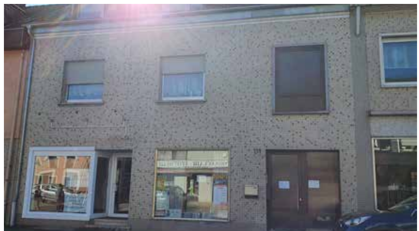
Leerstehende Gewerbeinheit im Bereich der ehem. Bundesstraße „Bezirkstraße“
