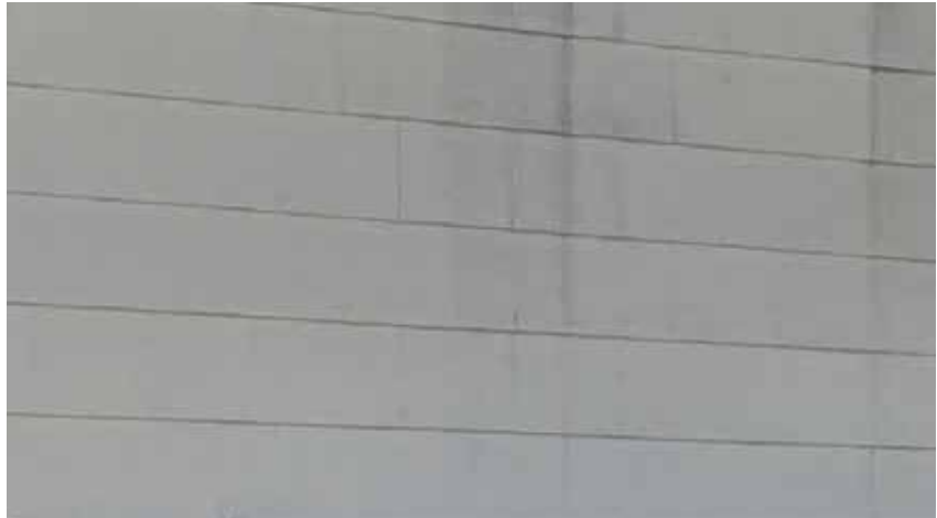
Misstand Beispiel: Materialität der Fassade
