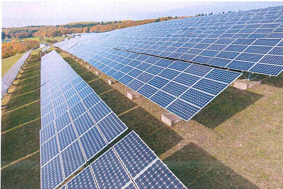
Bild 2: Solarpark auf der Deponie Fitten
