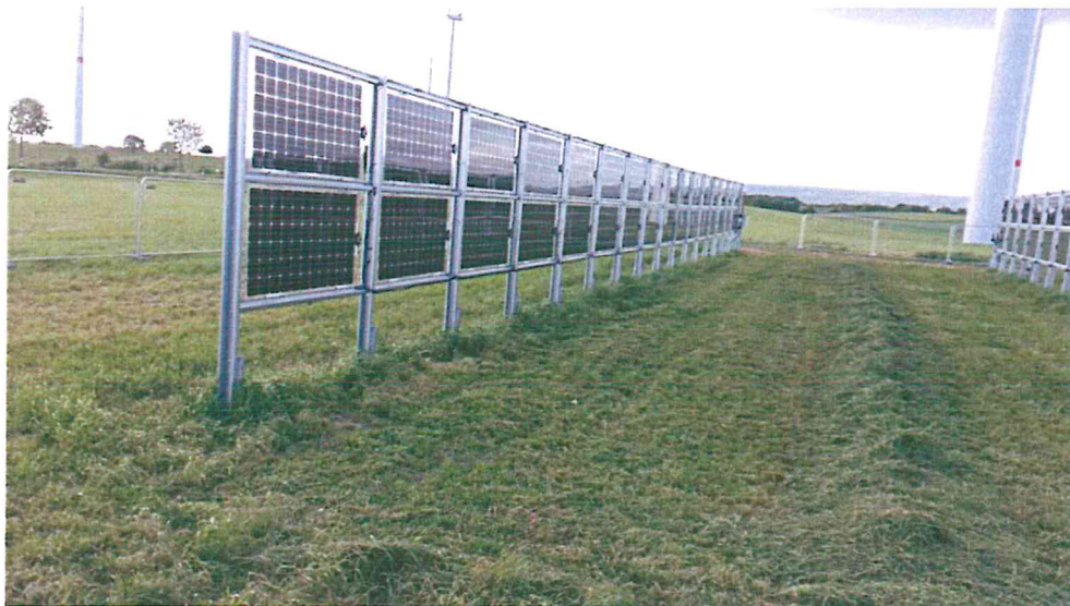
Bild 3: Pilotanlage in Losheim am See
