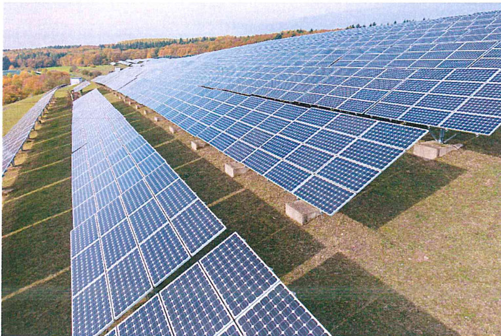
Bild 2: Solarpark auf der Deponie Fitten
