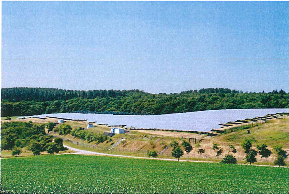
Bild 1: Solarpark auf der Deponie Fitten
